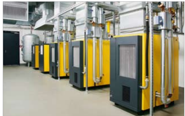
Installation von Abluftkanälen
