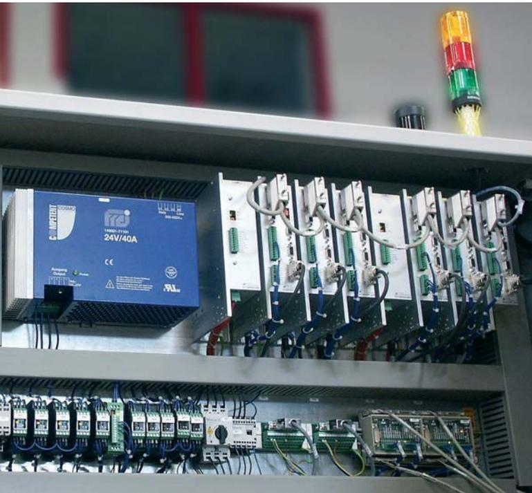
**CoDeSys in der Montageautomation:** E/A-Kanäle sowie Antriebe zur Bewegungssteuerung werden direkt in CoDeSys konfiguriert – die SoftSPS CoDeSys SP RTE steuert die Maschine.
